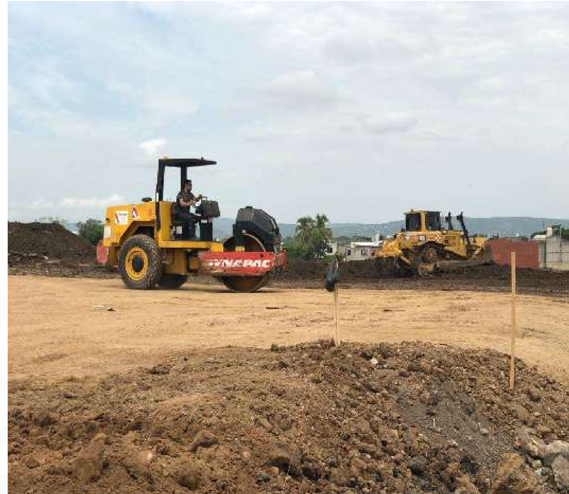
Trazos, niveles y conformación de plataformas
