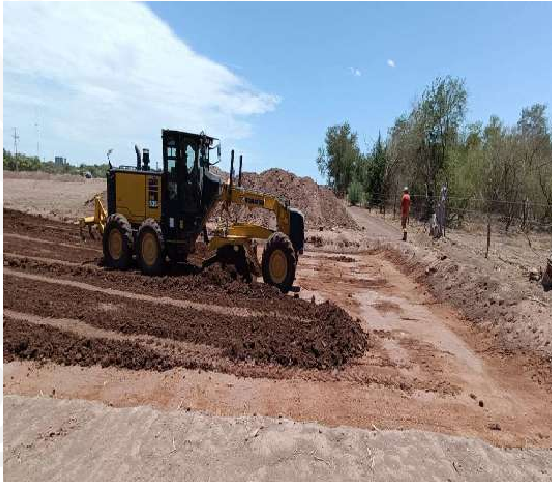
Tendido y compactación de terreno natural de plataformas
