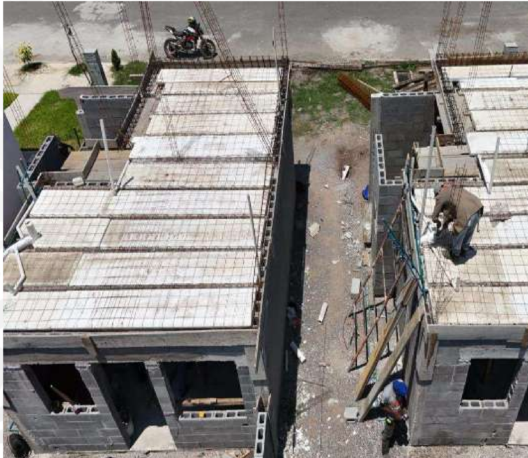
Colocación de cimbra para colado de losas
