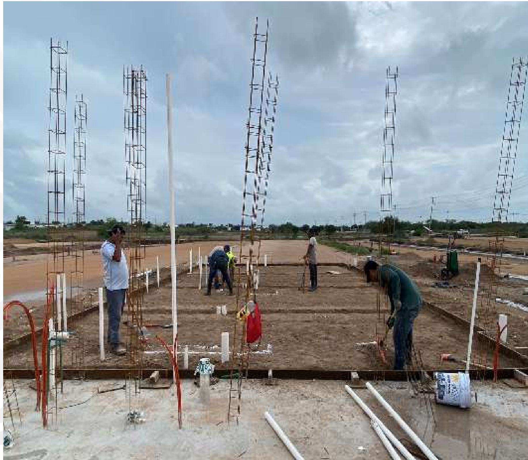
Excavación para instalaciones sanitarias
