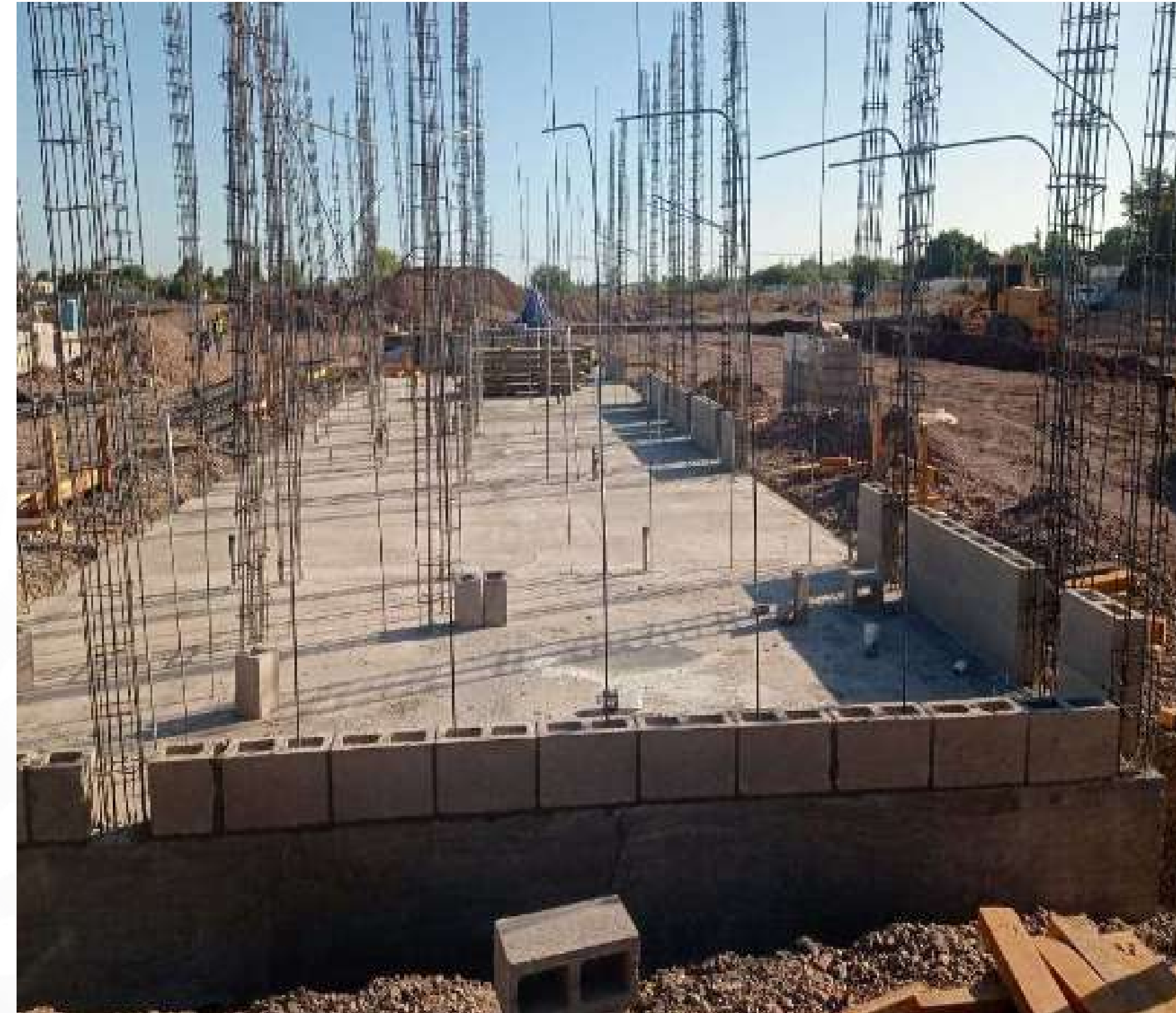
Inicio de colocación de block para muros en planta baja
