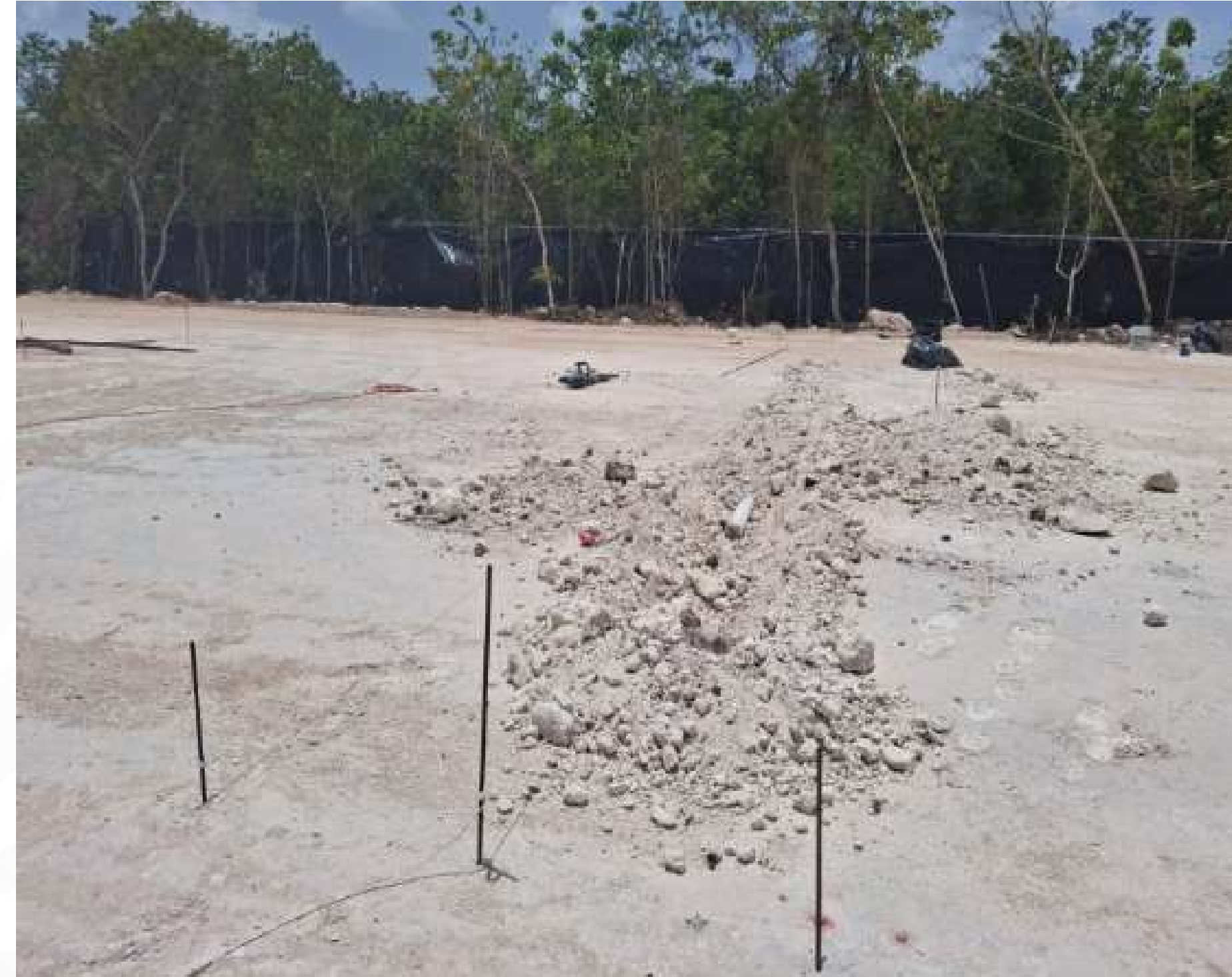
Trazo y nivelación para colado de cimentación de edificio
