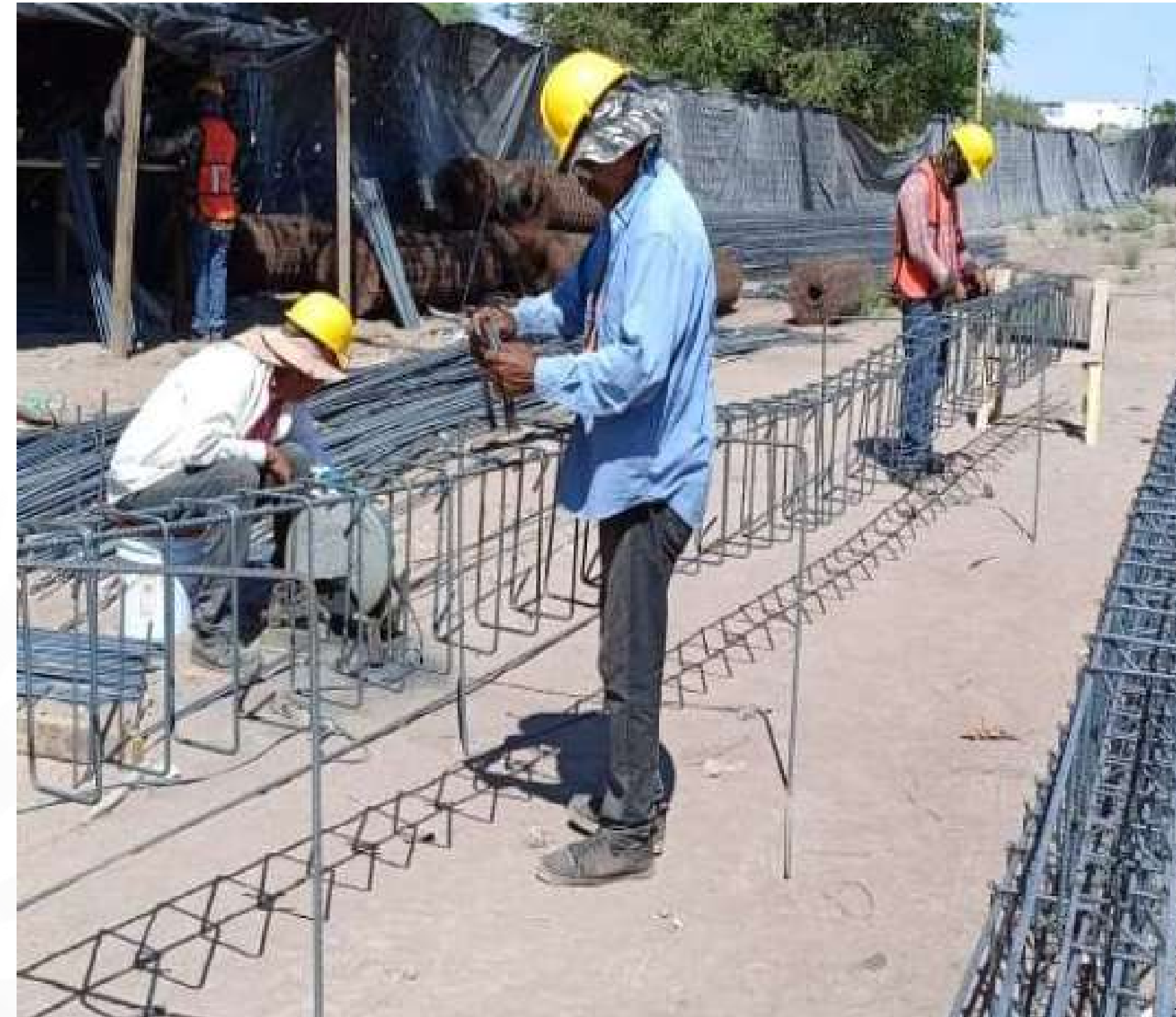
Habilitado y armado de acero de traves de cimentación de plataforma
