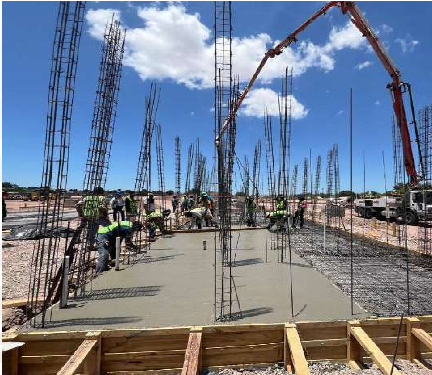
Vaciado de concreto
