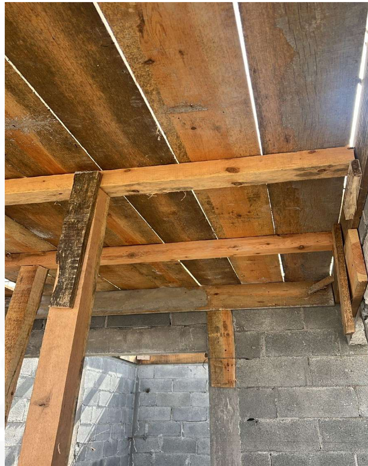
Preparación de losa de entrepiso
