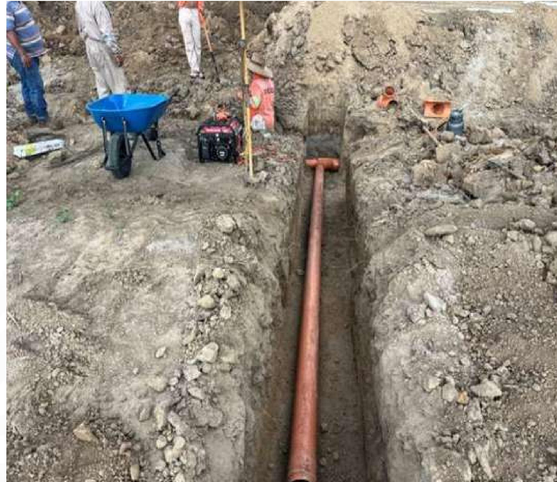
Ejecución apertura de zanjas para tubería
