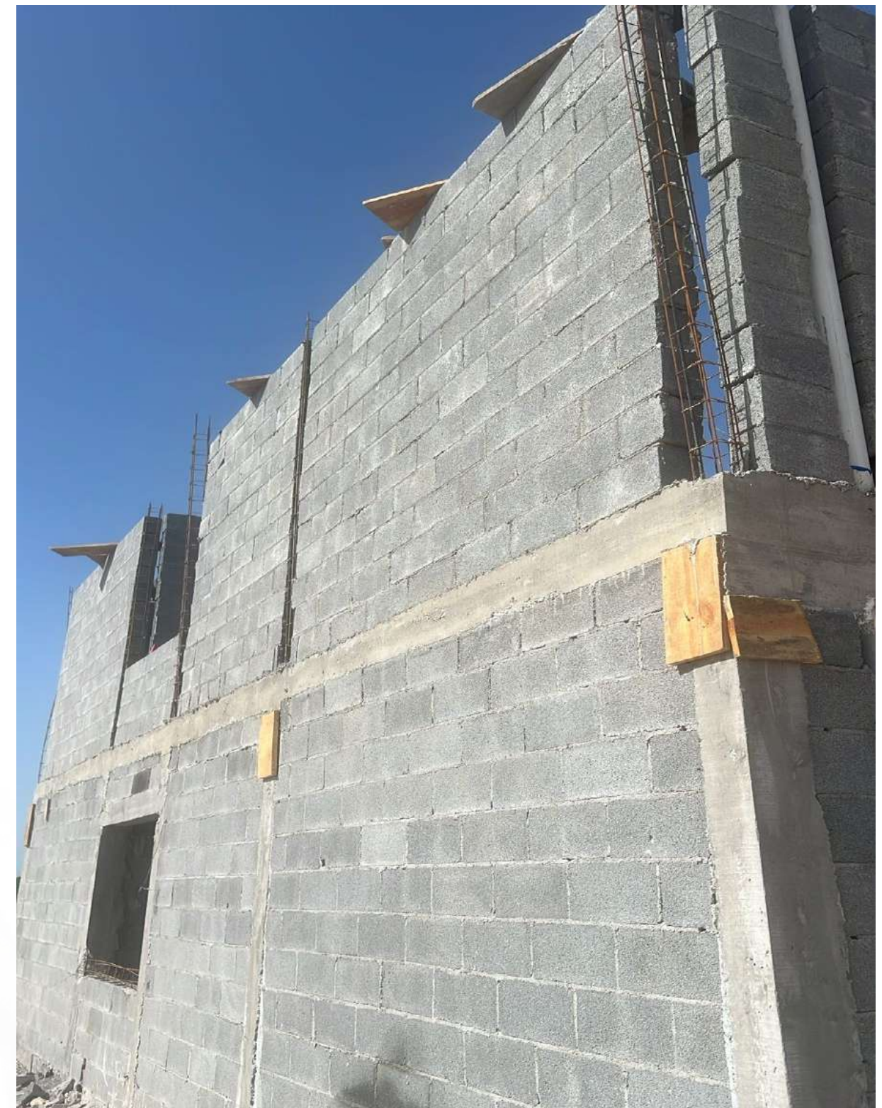
Levantamiento de muros del nivel 2
