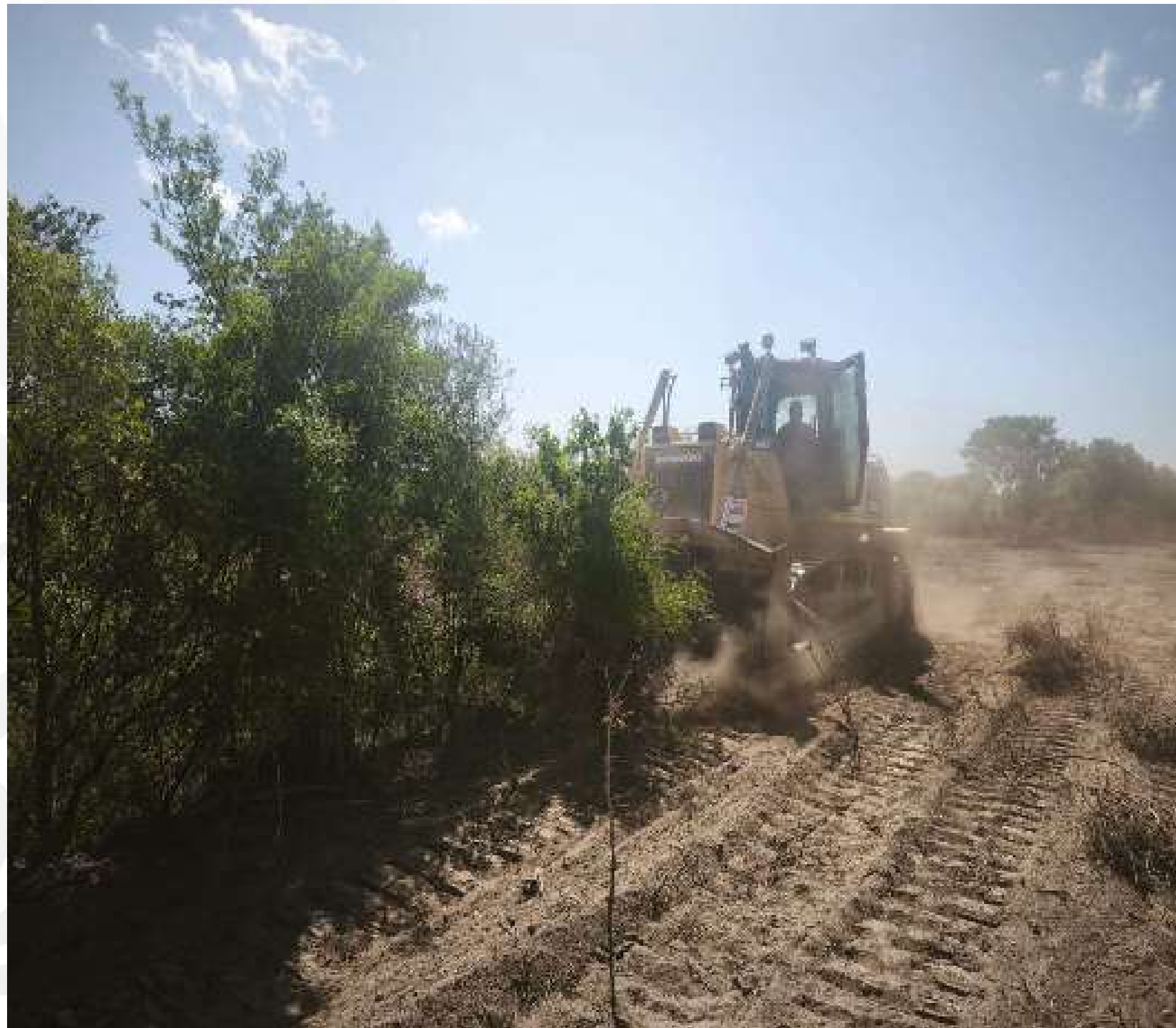
Bulldozer en proceso de desmonte de viabilidades y plataformas
