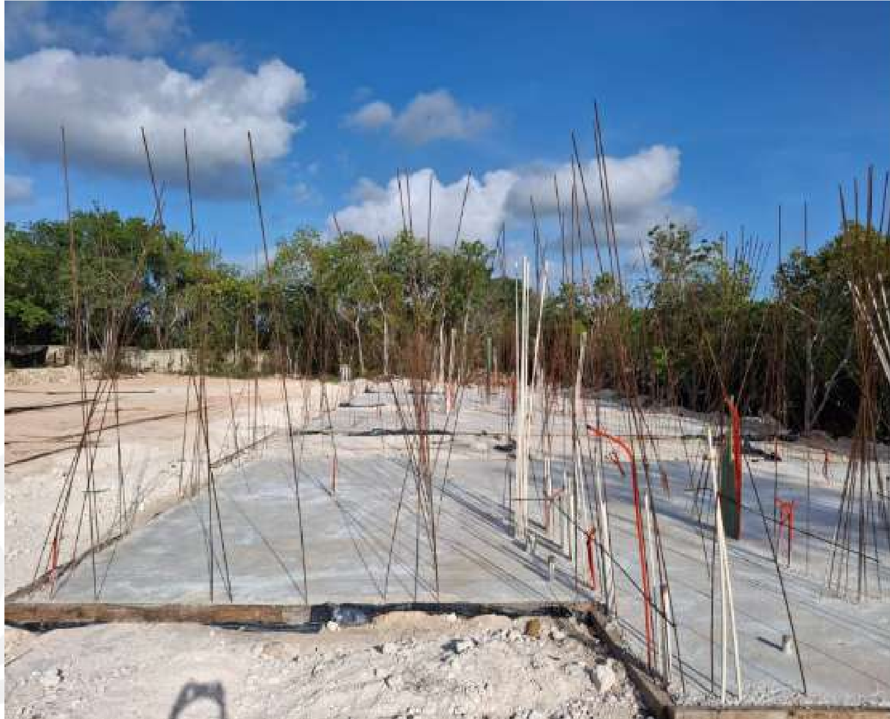
Colado de cimentación dúplex de edificios
